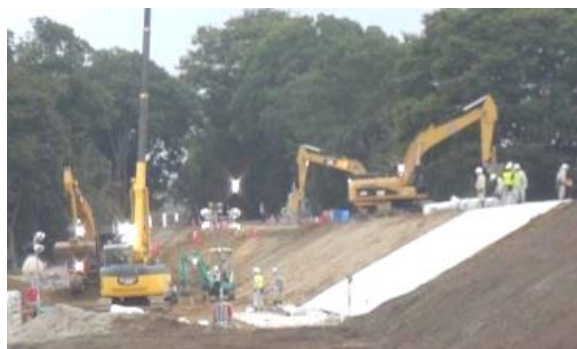
▲ 関東・東北豪雨応急復旧工事
